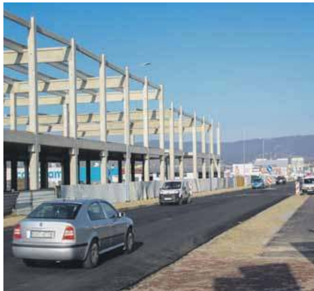
Ul. Szaflarska z nową nawierzchnią.
