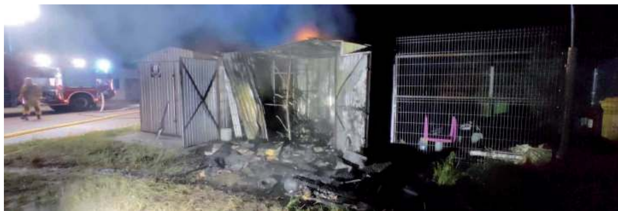
Jak informuje OSP KSRG Wólka Rokicka, straż pożarna otrzymała zgłoszenie o pożarze w sobotę o godz. 1.33. Palił się blaszany garaż przy stacji paliw przy ul. Lubelskiej w Lubartowie. Pożar ugasiły zastępy PSP z Lubartowa i OSP KSRG Wólka Rokicka. Na miejscu zdarzenia była też policja.
