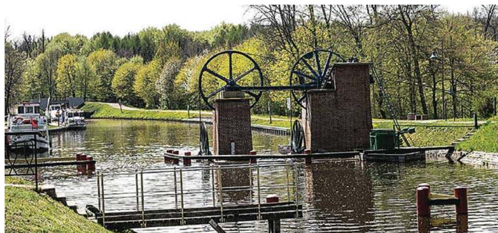
Koło wodne obraca się tylko w jednym kierunku obrotu bębna linowego
