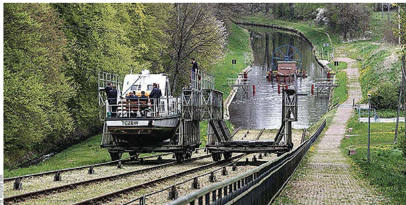
Jednostka pływająca pokonuje różne poziomy na specjalnym wózku po torowisku
