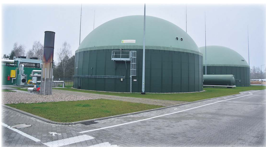
Na zdjęciu biogazownia w Bagdadzie o mocy 1 MW. W grudniu ubiegłego roku wyjazd do instalacji zorganizowała Gmina Lubiewo przy współpracy z KPODR-em.
