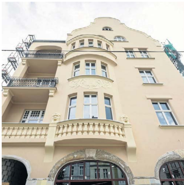
Budynek wpisano do rejestru zabytków w latach 90. XX wieku. Po remoncie wraca do oryginalnego wyglądu
