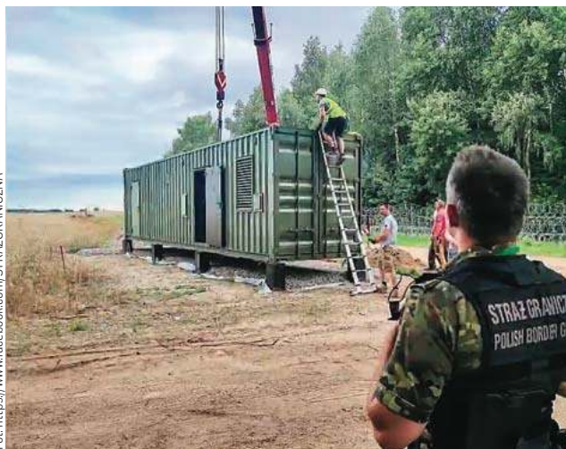
Na granicy z Rosją ustawiono już wszystkie kontenery bariery elektronicznej
