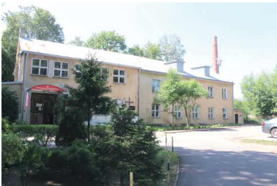
Przez wiele lat w willi Raabego znajdowało się przedszkole, a w latach 1940 – 1944 w tym budynku była siedzibą placówki niemieckiej Tajnej Policji Państwowej – Gestapo. W piwnicy otworzono cele więzienne. Budynek był miejscem torturowania ludności Podlasia
