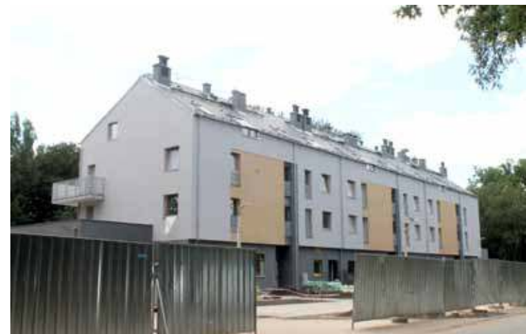
W tym nowopowstającym budynku mieszkalnym na Os. Kluczewo-Lotnisko od 1 września zacznie działać żłobek
