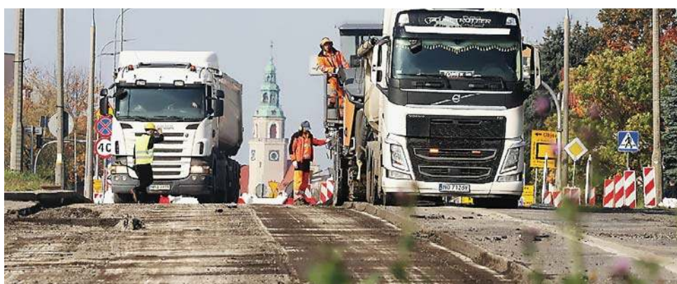
PAŹDZIERNIK. Budowy linii tramwajowej i przebudowy dróg. Zrywanie asfaltu na ul. Piłsudskiego
