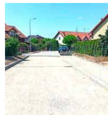
Trwa budowa drogi na ulicy Chełmońskiego. Obecnie zakończył się etap budowy kanalizacji deszczowej
