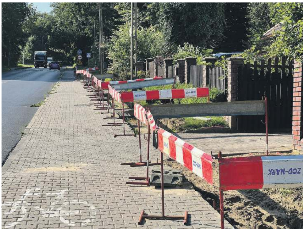
Trzebnica ul. Oleśnicka. Tak wyglądało zabezpieczenie wykopów przy poprawianej ścieżce rowerowej, a jak jest dzisiaj widać na zdjęciu obok
