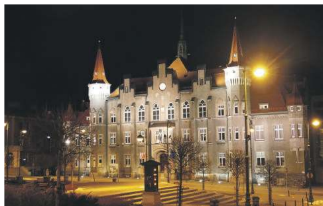
Budynek ratusza przy Placu Magistrackim.
