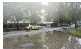
Podtopione osiedle przy ulicy Milickiej
