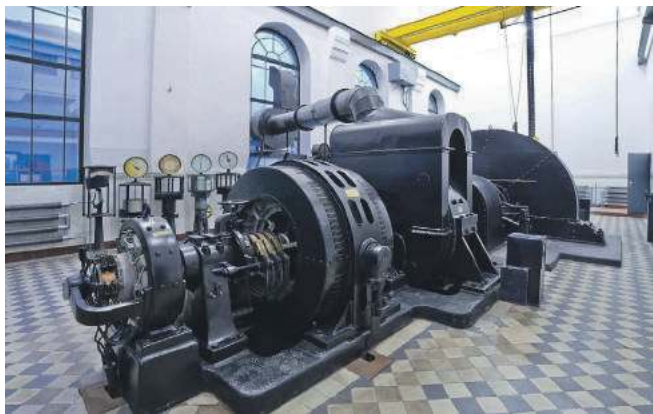
Napęd maszyny wyciągowej w Starej Kopalni.
