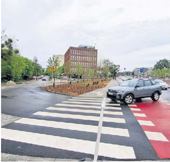
Tyle asfaltu wylano budując kolejne pasy między skrzyżowaniem Szosy Chełmińskiej z ul. Dekerta i Bema
