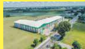
Nowoczesna hala przemysłowa o łącznej powierzchni 3 150 m 2 usytuowana na działce hektarowej w miejscowości Wołyń, 885 851 172
