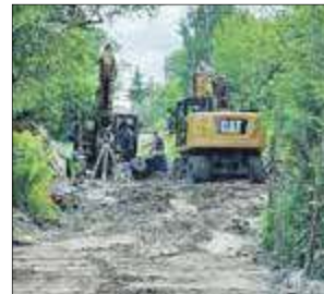
Na piętnastu odcinkach ulic w Terespolu trwa budowa kanalizacji sanitarnej
