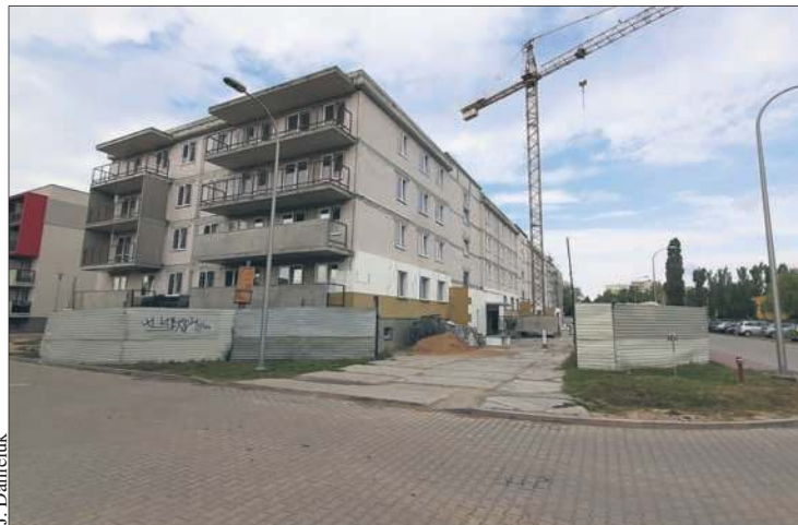
Trwa budowa kolejnego bloku MTBS przy ul. Kleeberga
