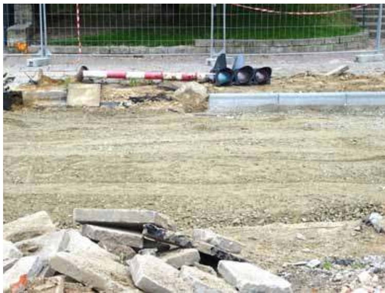
Stara sygnalizacja świetlna na Krasieńskiego wycięta. Mamy nadzieję, że zamontują nową.
