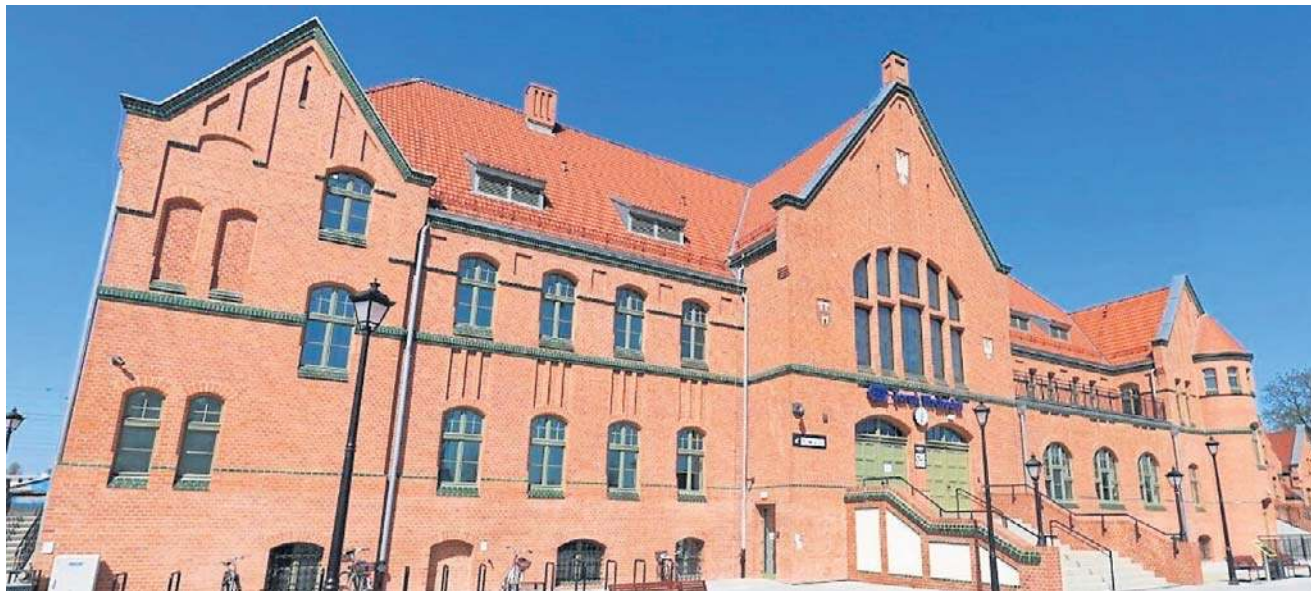
Stacją końcową dla obu przebiegających przez powiat toruński i ujętych w pakcie linii kolejowych jest wyremontowany niedawno dworzec Toruń Wschodni
