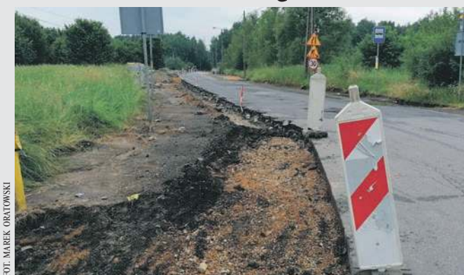
Trwa budowa drogi rowerowej na Powstańców Styczniowych w Chrzanowie
