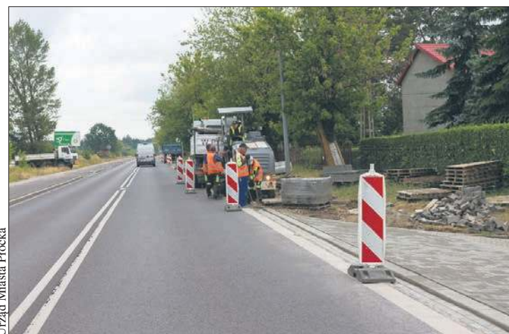
Chodnik wzdłuż ulicy Kutnowskiej ma być gotowy do końca wakacji
