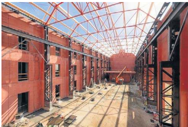
Tak obecnie wygląda budowa nowego śródmieścia i rynku w Dąbrowie Górniczej
