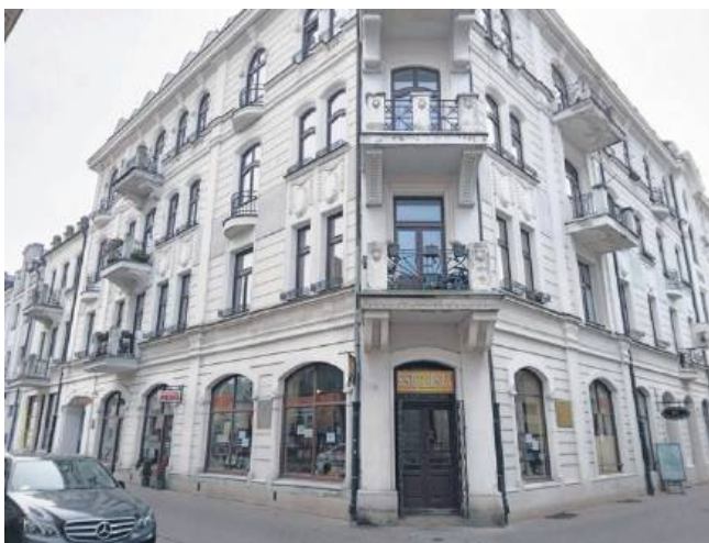
Obiekt z 1911 r. znajduje się w ścisłej ochronie konserwatorskiej.
