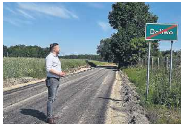
Przebudowa obejmie aż 13 odcinków dróg na terenie gminy.
