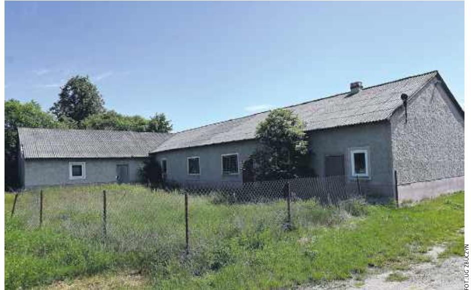
Budynek dawnej świetlicy wiejskiej będzie dostosowany do potrzeb magazynu.
