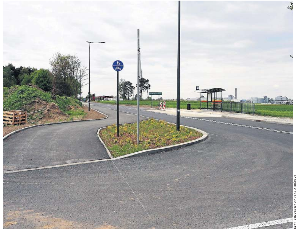
Nowo wyremontowany odcinek Szczecińskiej zostanie otwarty dla ruchu 24 maja
