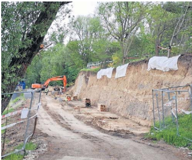
Budowa ścieżki wymusiła stworzenie stromej, piaszczystej skarpy, która martwi mieszkańców
