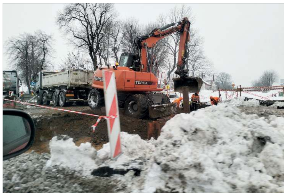
■ Remont przejazdu kolejowego w Studziennej
