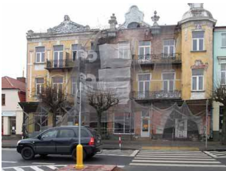
Obecny stan kamienicy „Pod cycami”
