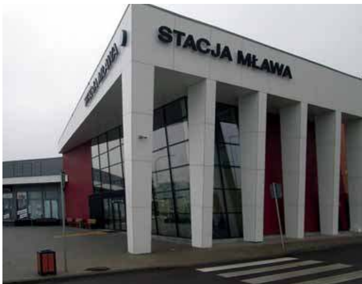
W nowym obiekcie będą kolejowe i autobusowe kasy biletowe
