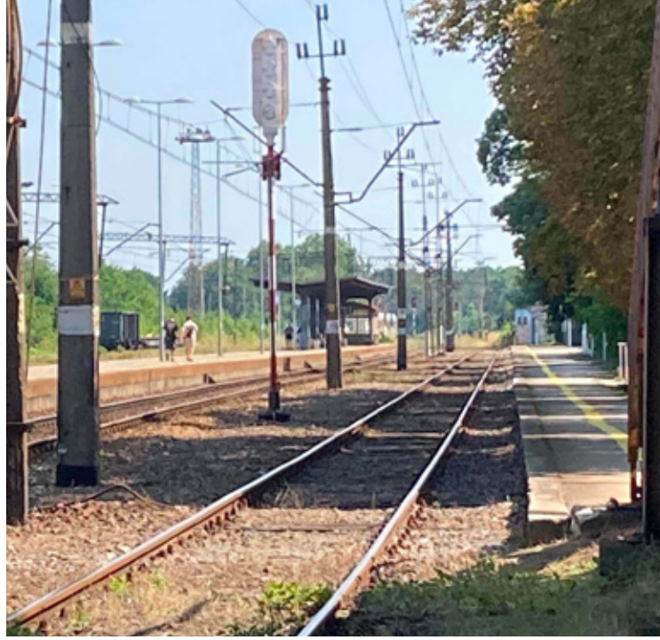
Kładka nieczynna, krótsza droga kusi.
