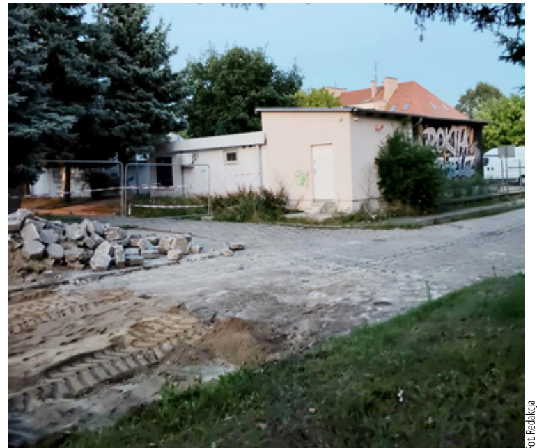
Prace się rozpoczęły.
