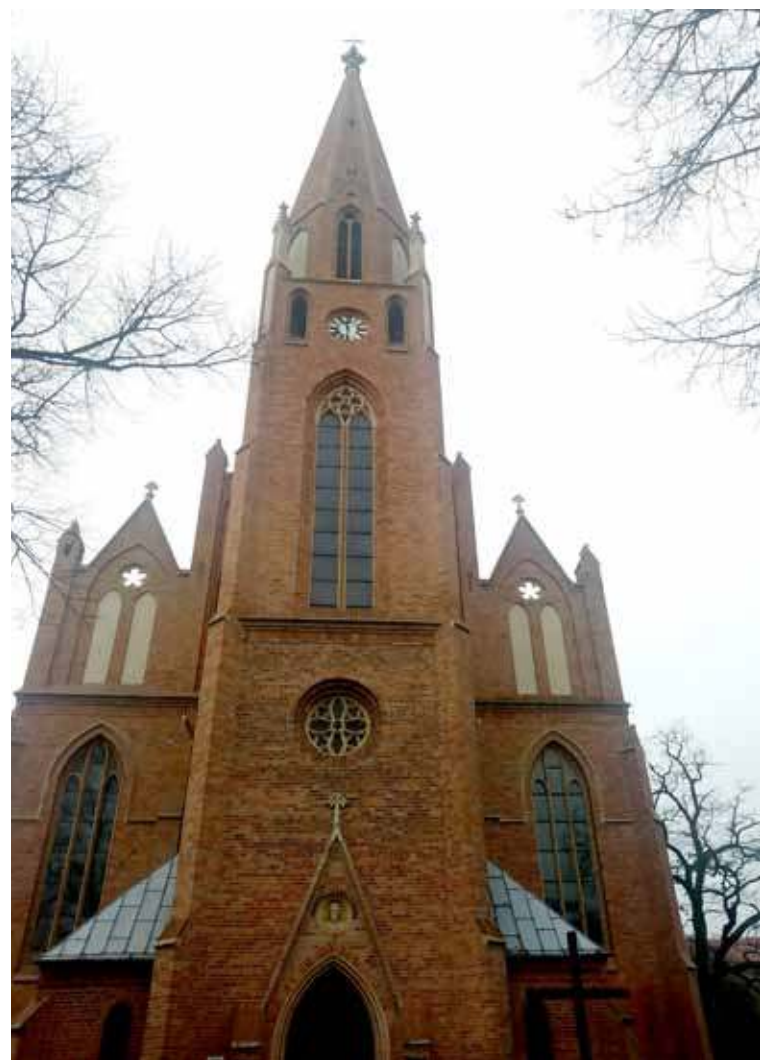
Przed tygodniem w piątek firma spod Wrocławia wykonała pomiary hałasu emitowanego z dzwonnicy kościoła przy ul. Warszawskiej
