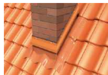
● Obróbki blacharskie są niezbędne na styku pokrycia i innych elementów budynku, np. wokół komina. WIENERBERGER
