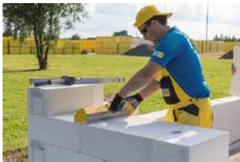
❷ Zaprawę cienkowarstwową i klej poliuretanowy w postaci pianki nakłada się precyzyjnie za pomocą specjalnej pacy lub aplikatora. Cienka warstwa spoina gwarantuje, że ściana będzie pozbawiona liniowych mostków cieplnych. YTONG (XELLA)
