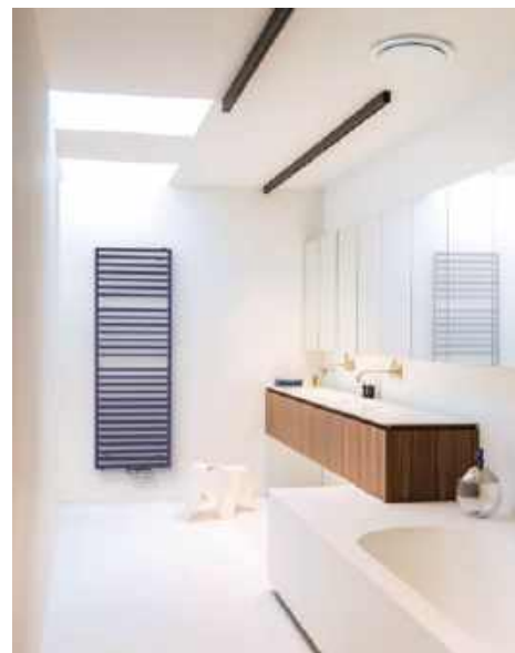
❸ W budynkach z wentylacją mechaniczną zamiast krat mamy anemostaty na suficie. VASCO
