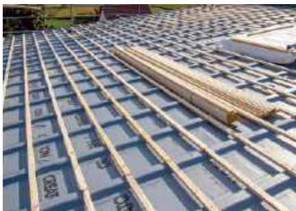
🔧 Ołacenie z membraną wstępnego krycia wykonuje się pod blachodachówki oraz płyty faliste. CREATON POLSKA
