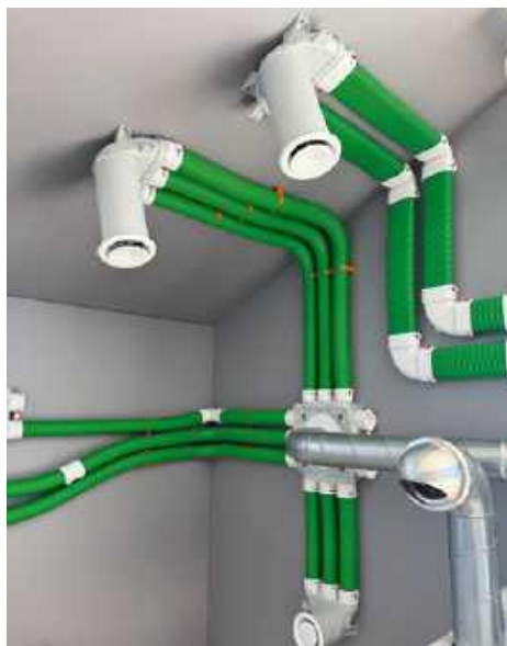
❷ Elementy instalacji wentylacji mechanicznej – kanały elastyczne, rozdzielacze, skrzynki rozprężne. VENTS GROUP
