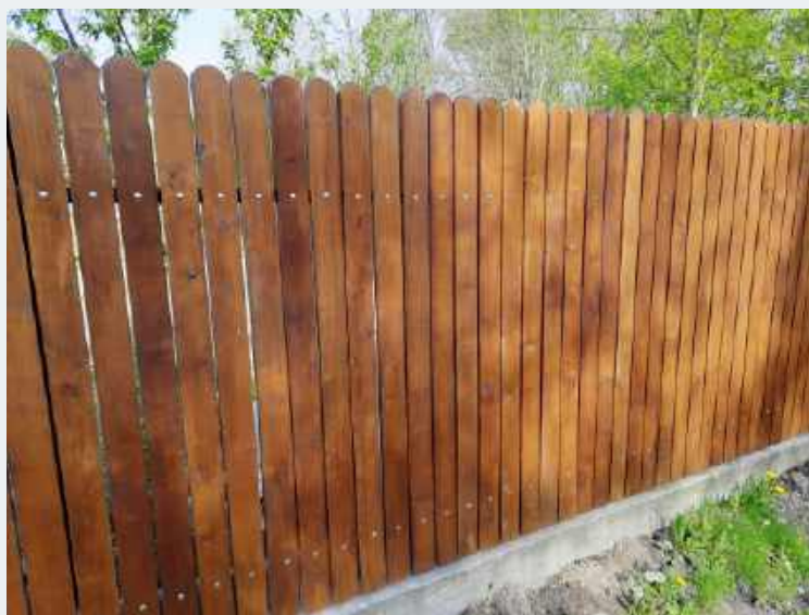
➔ Sztachety przytwierdzono śrubami do płaskowników ze stali (poziomych).
