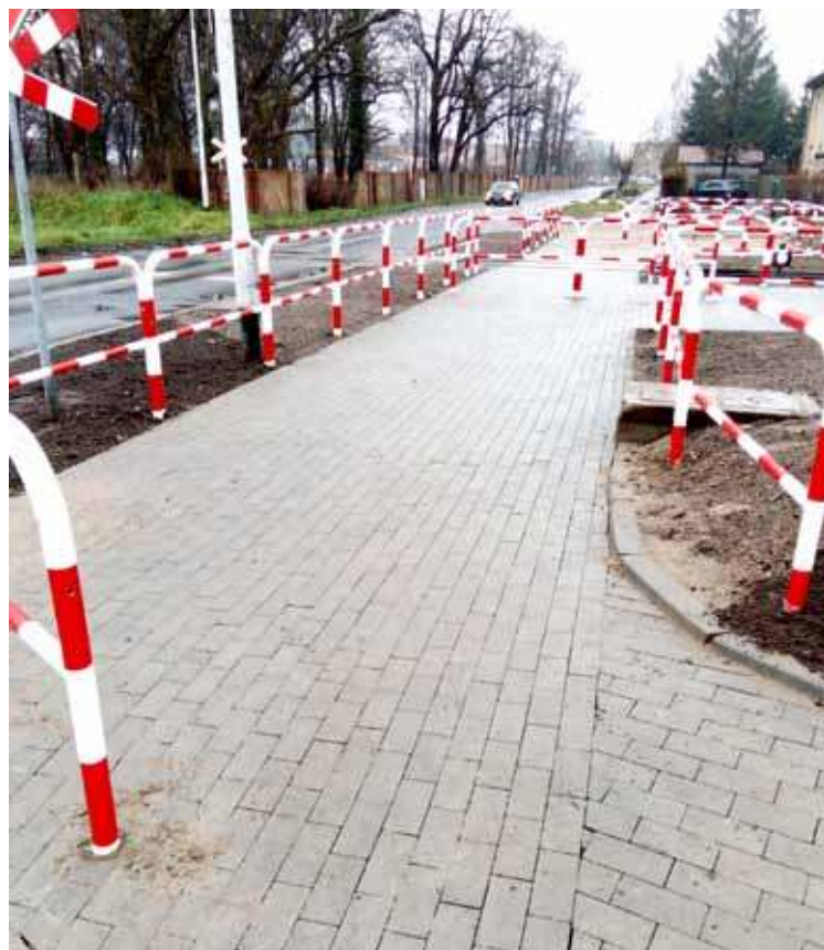
Mieszkańcy osiedla Kluczewo mogą korzystać z nowego chodnika. Dla bezpieczeństwa pieszych postawiono również barierki
