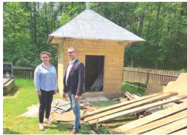
Na miejscu prac przy kaplicy pw. św. Antoniego w ubiegłym tygodniu pojawiła się zarówno wójt gminy Kąkolewnica Anna Mróz, jak i wójt gminy Radzyń Podlaski - Daniel Grochowski
