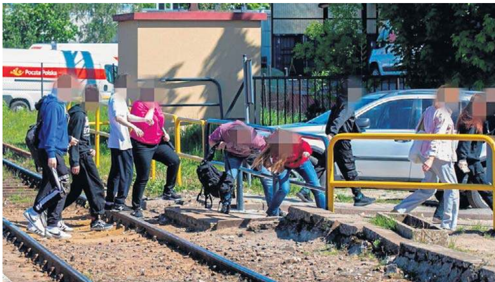
Barrierki w miejscu dawnego przejścia technicznego nie stanowią przeszkody dla niektórych pasażerów
