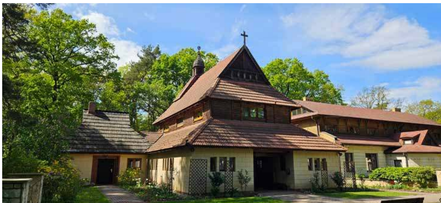
Kaplica Matki Bożej Anielskiej przy domu zgromadzenia w Laskach – widok z zewnątrz Fot. Archiwum Zgromadzenia Sióstr Franciszkanek Służebnic Krzyża
