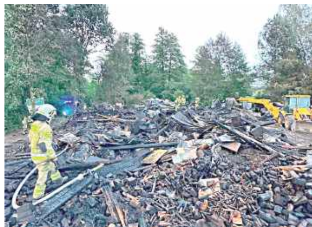
Niestety, budynków nie udało się uratować
