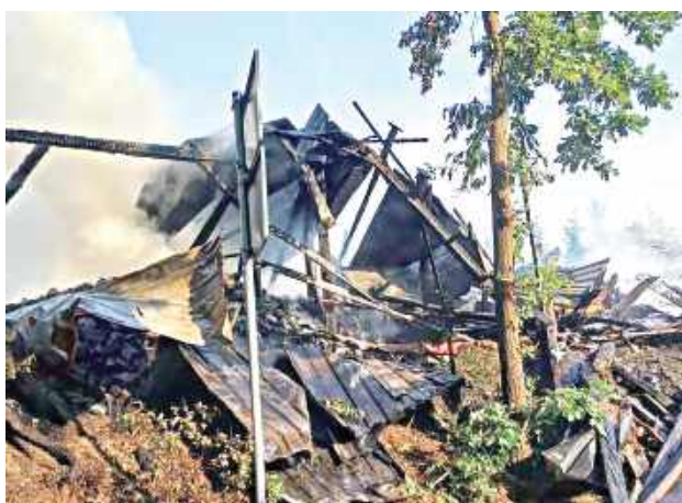
26 lipca po południu strażacy zostali wezwani do pożaru budynków gospodarczych w Niecieplinie
