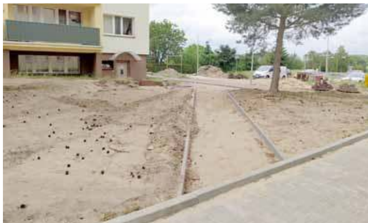
Do ukończenia prac pozostał niewielki odcinek ciągów pieszych
