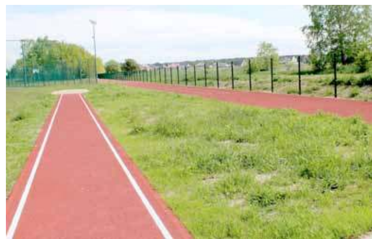
Za budowę obiektu znajdującego się za Orlikiem, gmina Nowogard zapłaciła prawie w całości z własnych środków
