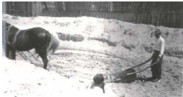
Budowa ul. Batalionów Chłopskich
