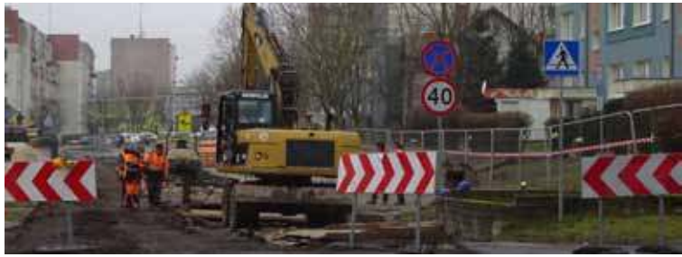
Zgodnie ze śródowną zapowiedzią A. Durmy, w czwartek wykonawcy wrócili na plac budowy
