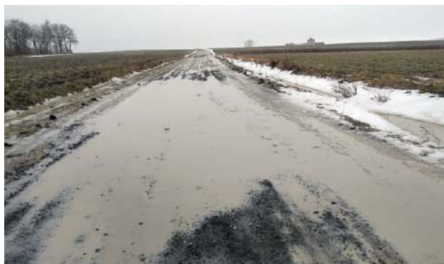
Remont w formie stabilizacji podłoża gruntowego przeprowadzono w 2020 r. Dziś na drodze widać ubytki.
