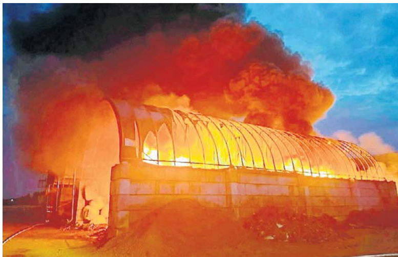
Pożar na terenie sortowni odpadów w Jędrzejowie
