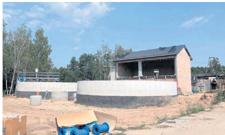
W miejskiej oczyszczalni ścieków w Zwoleń są nowe zbiorniki. Prowadzone są prace wykończeniowe w budynku technicznym.
