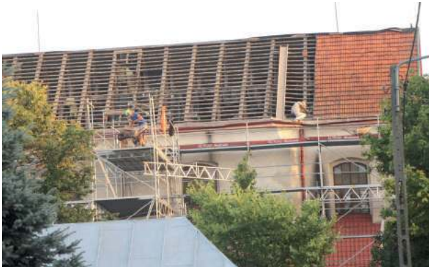
Trwają prace przy wymianie dachu na kościele oo. Kapucynów
