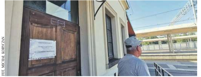
Publiczna toaleta w budynku dworca PKP w Trzebini jest nieczynna
