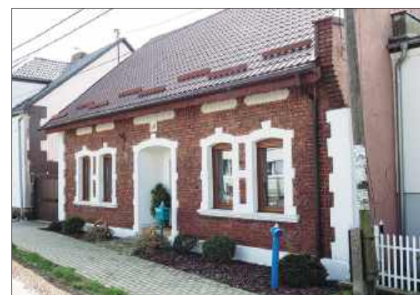
■ Dom przy ulicy Janowskiej z lukowymi portalami okiennymi i drzwiowymi
