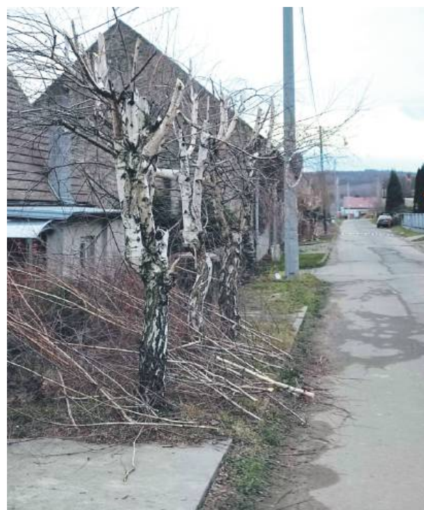
Ogłowione brzozy nie będą przez jakiś czas dotykały znajdującej się nad nimi linii energetycznej. Po ich przycięciu na poboczu drogi pozostały spore ilości gałęzi do posprzątkania
