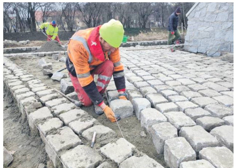
Plac obok remontowanej drogi układany jest również z dużej granitowej kostki. Takie miejsce będzie odporne na większe obciążenia i bardzo trwałe
