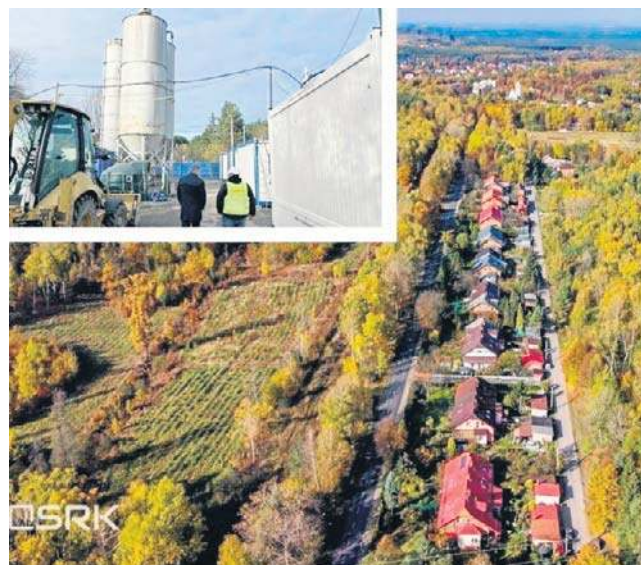
Trwają kosztowne zabezpieczenia. W Trzebinii włożono do gruntu blisko 60 tys. m³ mieszaniny stabilizującej
