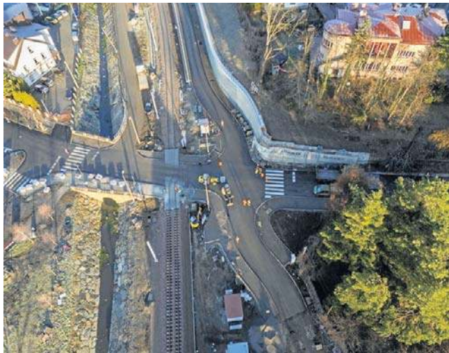
Ulice Kościuszki i Szwedzka po przebudowie. Wraca tam ruch pojazdów
