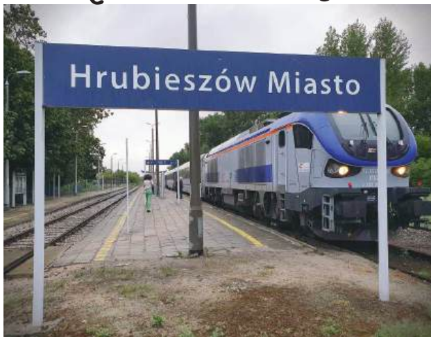
Finał robót w Hrubieszowie zaplanowano na 30 października tego roku.
