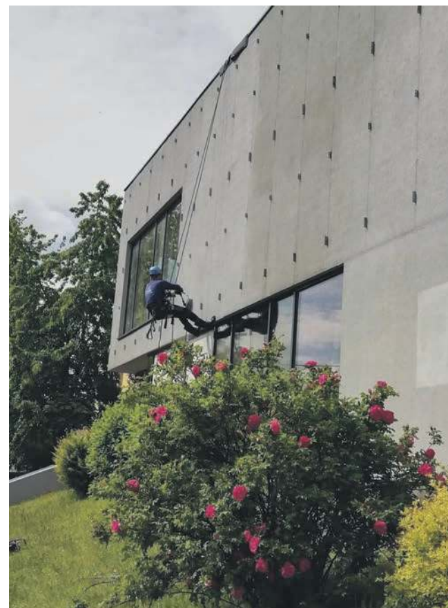
Wykonywane przez Silver-Service roboty wysokościowe
