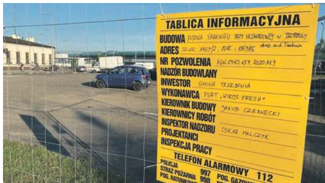
Prace rozpoczęto od ogrodzenia terenu budowy
