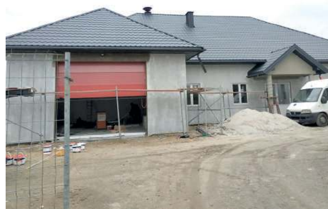
Zakończono budowę Wiejskiego Domu Kultury w Woli Chomejowej. Trwają prace końcowe i odbiorowe budynku. Przypominamy, że projekt rozpoczął się w roku poprzednim, miał kosztować 900 tysięcy złotych. Na zakup wyposażenia do świetlicy kwota zabezpieczona to 80 tys. zł brutto, procedura przetargowa jest w toku
