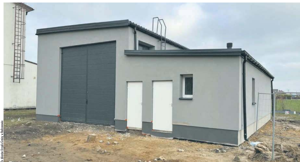
Trwa drugi etap remontu budynku, który będzie pełnił funkcję gminnego magazynu ochrony i obrony cywilnej w Radzanowie
