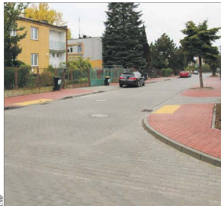
W efekcie przedsięwzięcia powstała nowoczesna infrastruktura podziemna
