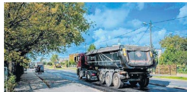
Prace drogowe na ulicy Grunwaldzkiej w Wągrowcu. Drogowcy wylali asfalt.
