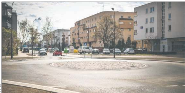
W najbliższych miesiącach prace remontowe będą prowadzone na ul. 3 Maja od ronda do al. Kilińskiego
