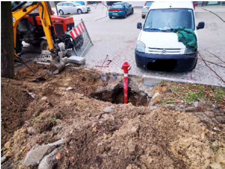
Prace wokół hydrantu.
