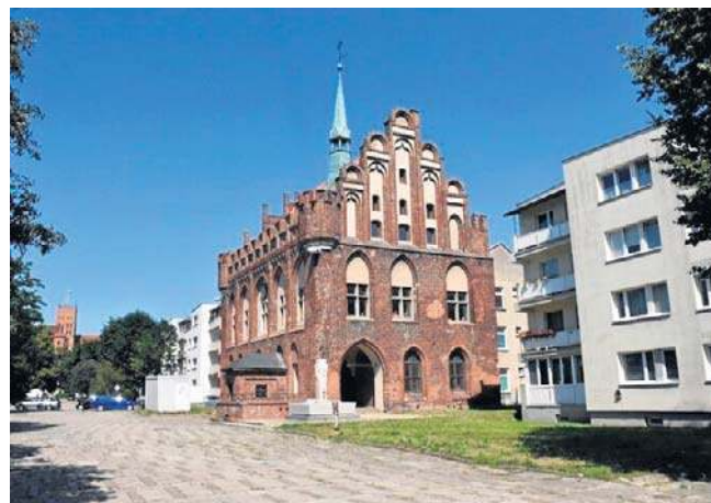
Ratusz Staromiejski w Malborku. Trwa jego remont, ale zabrakło nie aparatury służącej do odtwarzania hejnału
